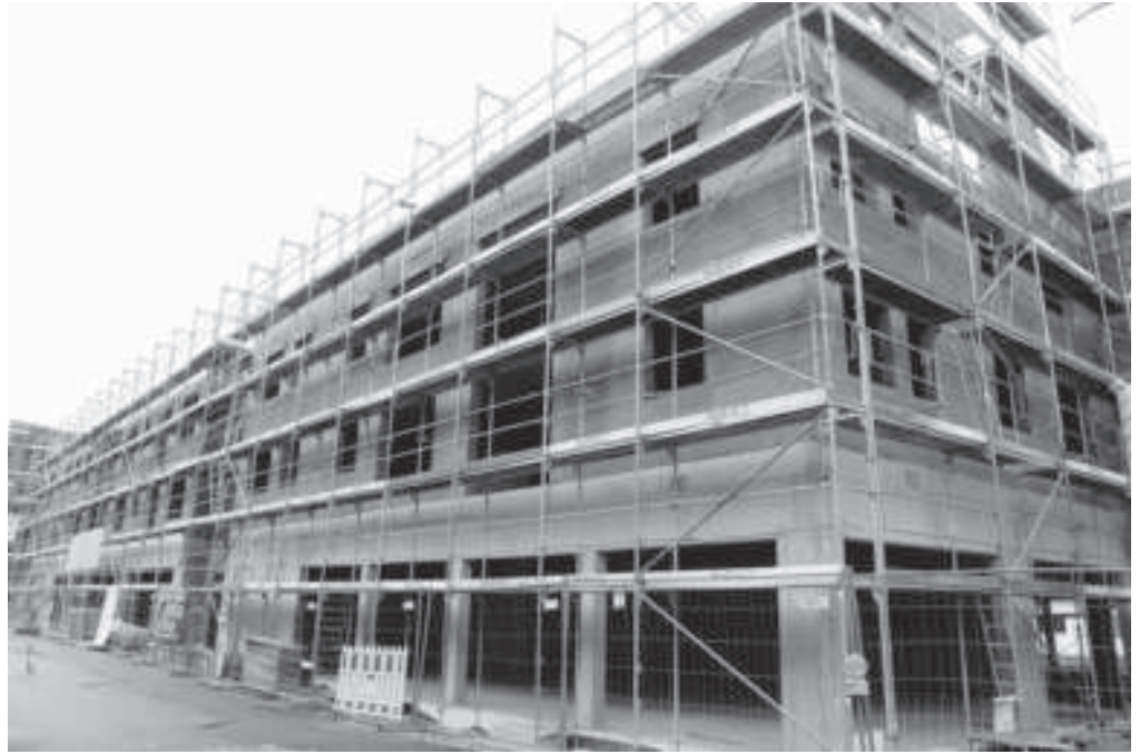
Der neue Gebäudekomplex an der Rennstraße nimmt sichtlich Gestalt an.
